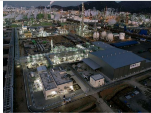
그림 4. 디렉스폴리머 플랜트(APAO) 전경
